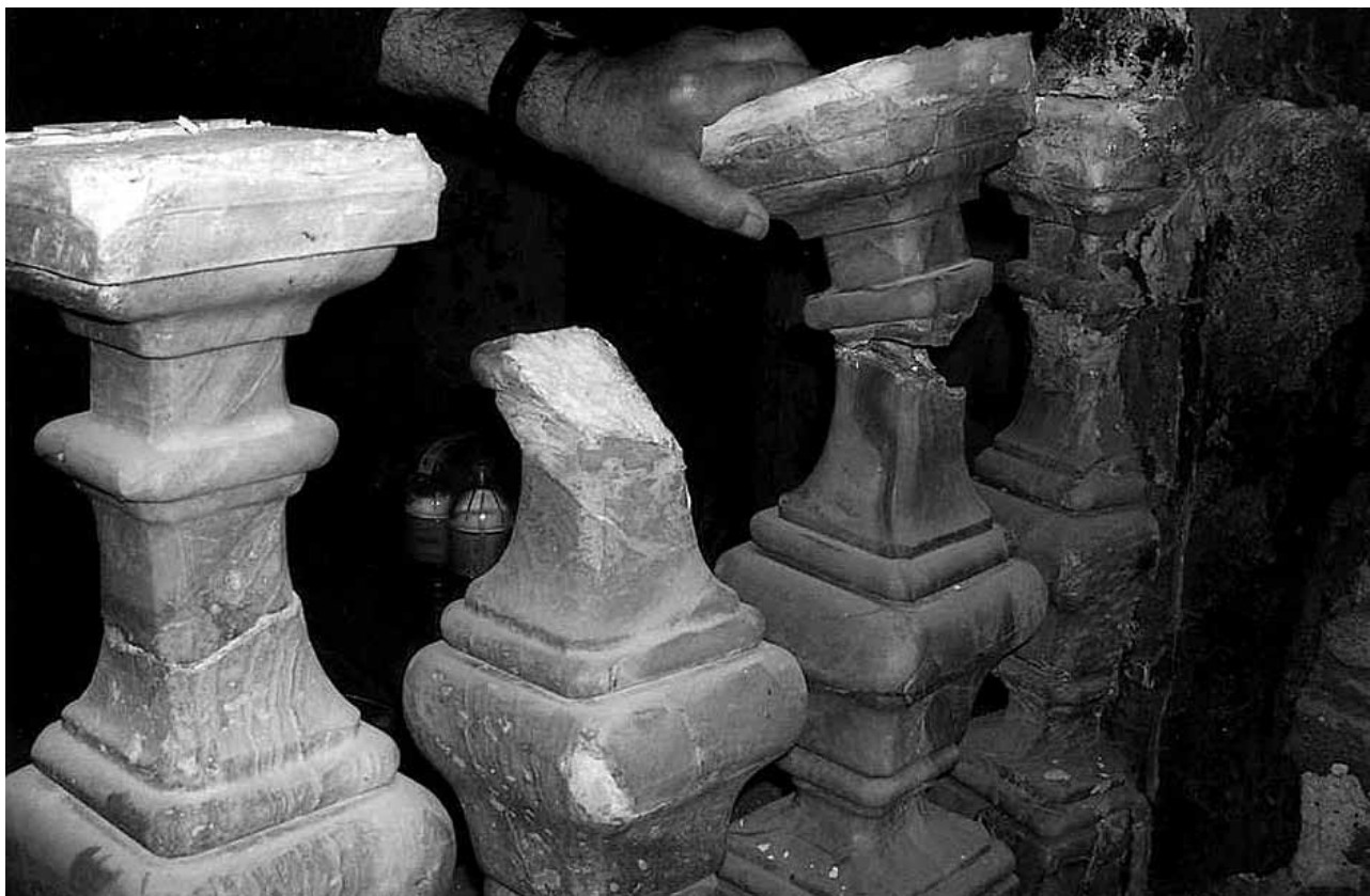
Fig. 12 – Cagliari, basilica di Santa Croce, particolare del restauro delle balaustre
