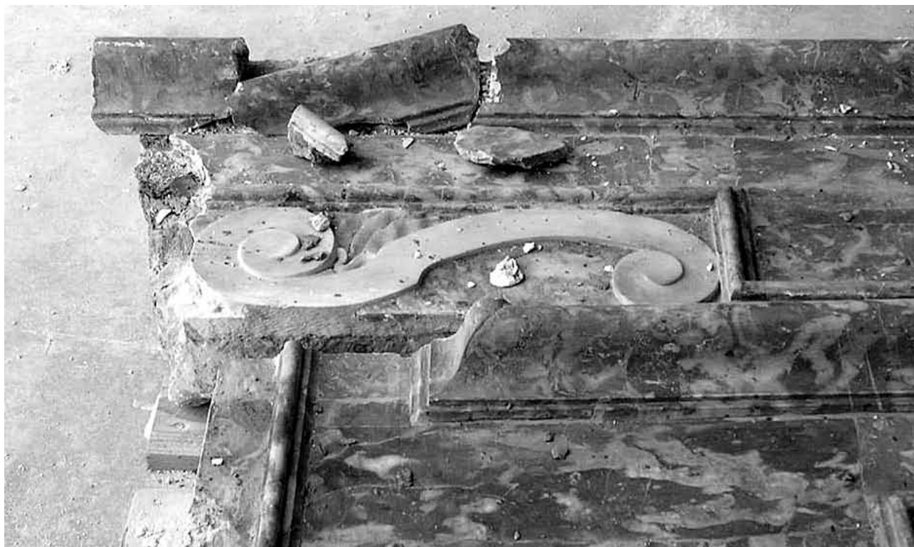
Figg. 13-14 – Cagliari, basilica di Santa Croce, particolare del restauro degli altari.
