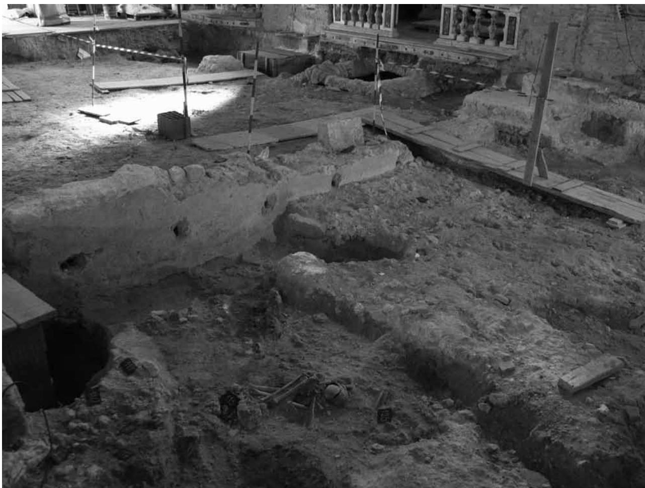
Figura 3. Cagliari, chiesa Santa Croce. Particolare del muro meridionale con i fori per l'infissione di puntelli lignei.
